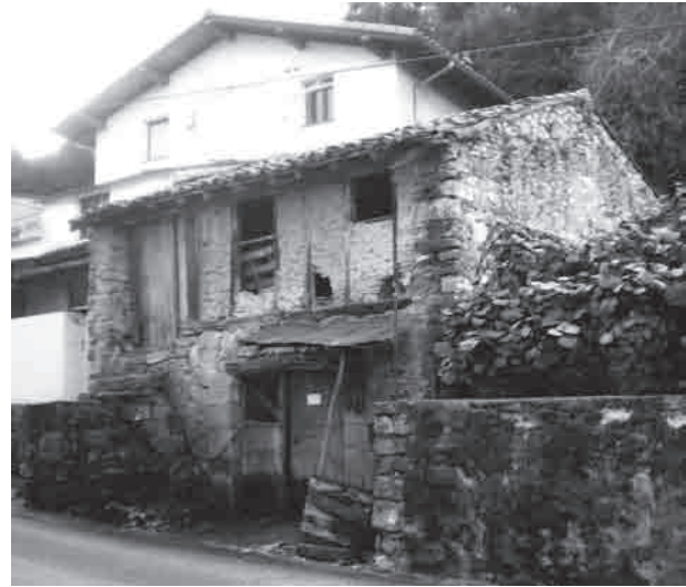
Fig. 57. Antigua construcción situada en un ecléctico conjunto arquitectónico no muy alejado del hórreo de Liendo. La planta superior, en este caso de piedra y arcilla, también está cerrada con tabique septado por pilares de madera.
