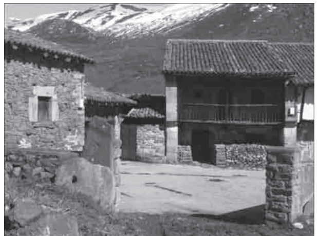
Fig. 75. Restos del hórreo de Belmonte en la actualidad (Marcos y Mantecón, 2010)
