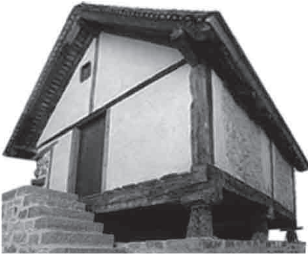
Fig. 56. Hórreo en Aézkoa, en uno de los valles pirenaicos navarros a unos 200 km al Este, de estructura constructiva similar al existente en el barrio del Noval de Liendo, en la zona costera oriental de Cantabria.
